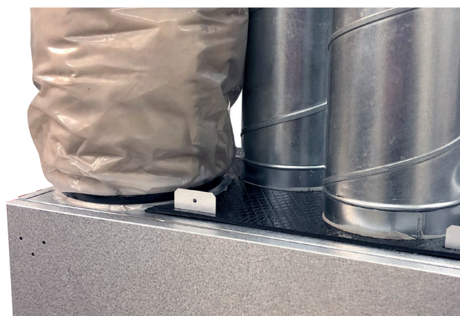
Figur 10 Ferdig monterte kanaler
